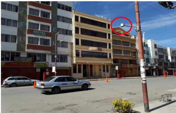
Figura 1. Vista general del sitio Terminal de Buses (TB)
