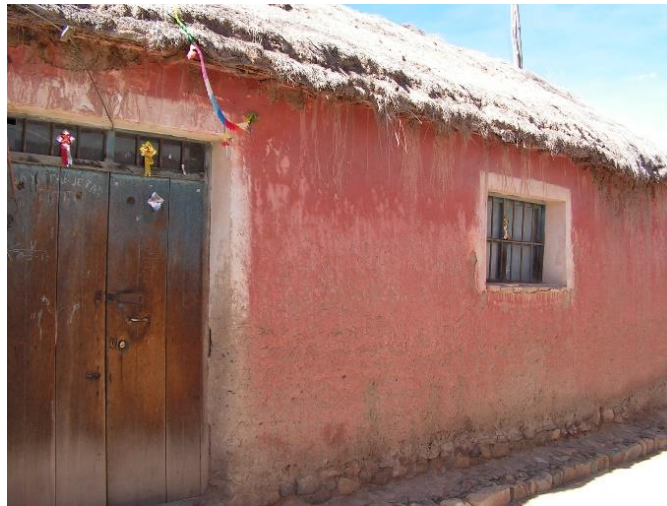
Figura 57: Viviendas con techo de paja, Villa Poopó.
