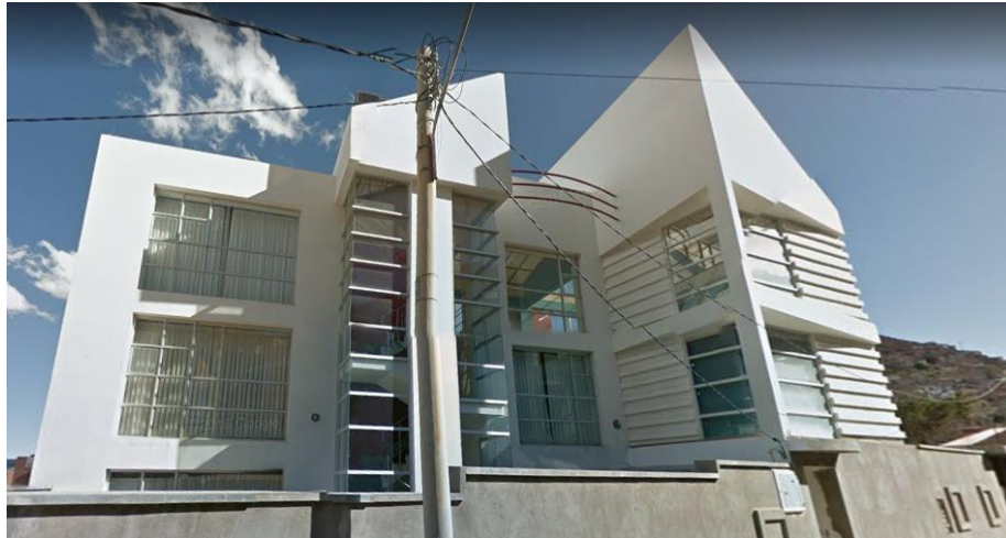
Figura 51: Arquitectura bioclimática, vista de frente, Oruro
