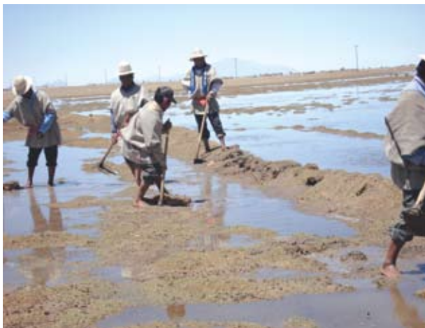
Construcción comunal de dique para lameo
