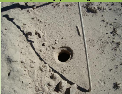
Cámara de inspección
