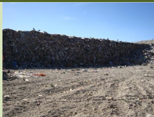
Frente de trabajo previo a su cobertura
