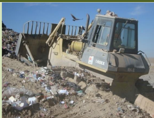
Rodillo compactador en el frente de trabajo
